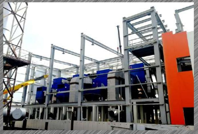
Монтаж котельной тепловой мощностью 30,24 МВт с четырьмя котлами КВ 7,56-100 ШпВТ, теплоноситель - антифриз, Кемеровская область
