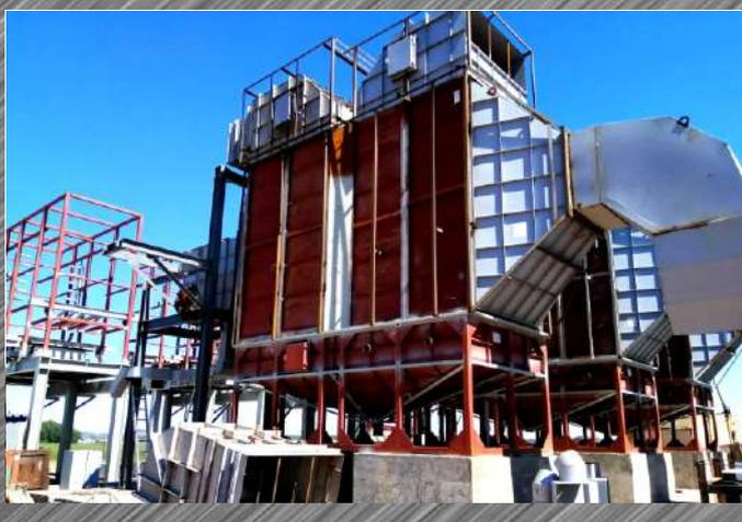
Монтаж комплекса теплогенерирующей установки (ВНУ) с тремя теплогенераторами тепловой мощностью 7,56 МВт, Кемеровская область
