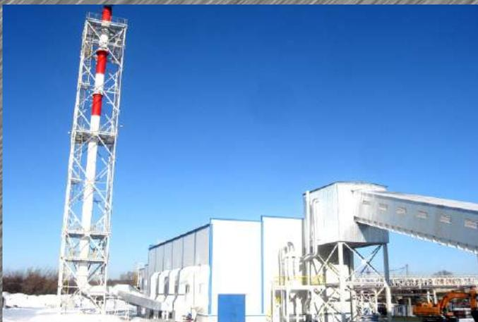
Котельная тепловой мощностью 42 МВт с шестью котлами КВ 7,0-110 ШпВТ, теплоноситель - антифриз, Кемеровская область
