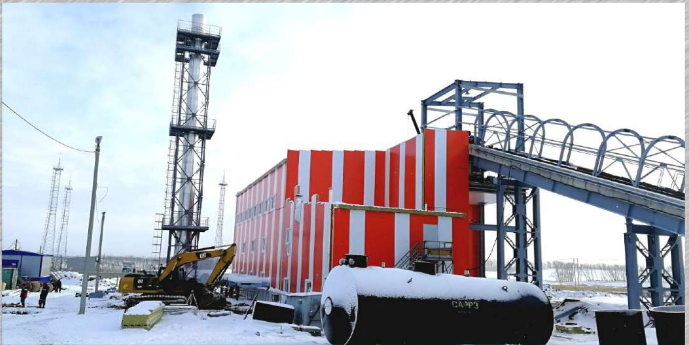
Котельная тепловой мощностью 30,24 МВт с четырьмя котлами КВ 7,56-100 ШпВТ, теплоноситель - антифриз, Кемеровская область
