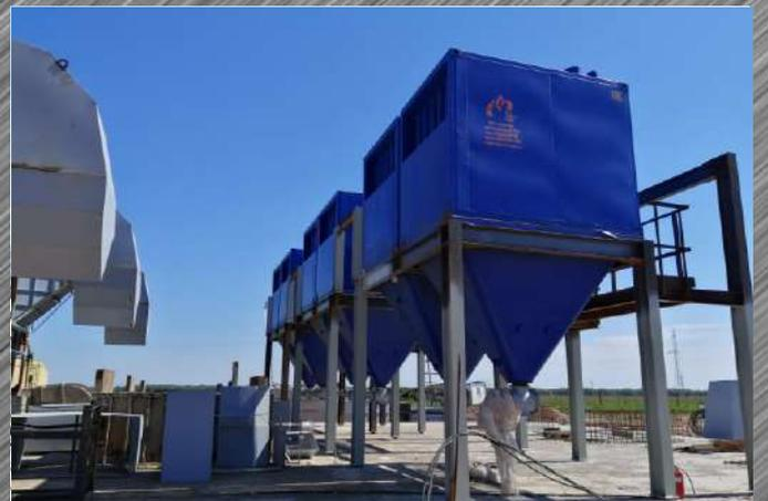
Монтаж батарейных циклонов БЦф 6\*8сч комплекса теплогенерирующей установки тепловой мощностью 22,68 МВт, Кемеровская область.
