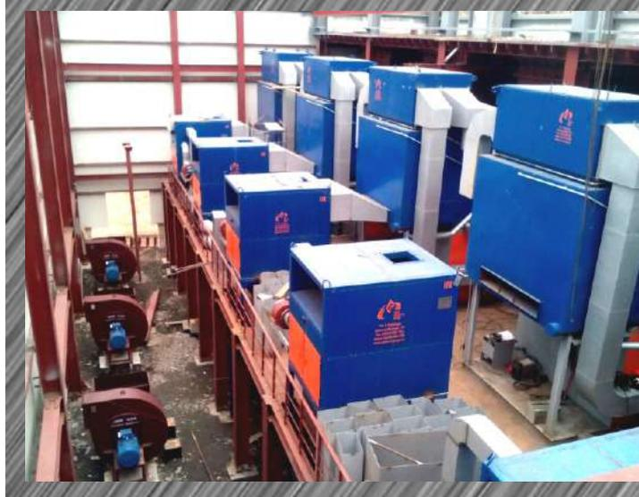
Монтаж котельная тепловой мощностью 37,8 МВт с пятью котлами КВ 7,56-110 ШпВТ, теплоноситель - антифриз, Кемеровская область
