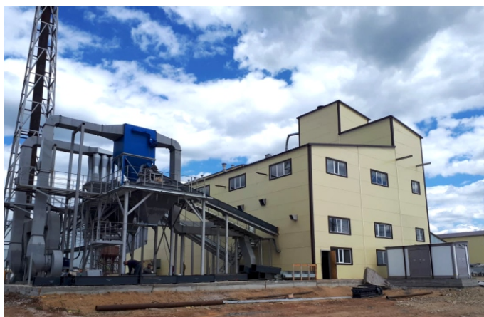
Фото 3 — Трехтопливная паровая котельная на базе двух котлов Е-10-1,4 ОИ на лузге подсолнечника и костре льна и Е-10-1,4 на угле, Республика Казахстан
