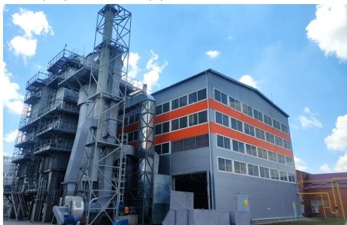
Фото 8 — Паровая котельная с котлом Е-20-1,5-360 ОИ, основное топливо — лузга подсолнечника, резервное топливо — природный газ, Краснодарский край
